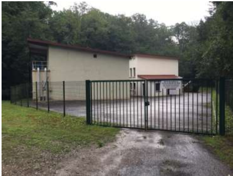
Forage n°1 et installation de traitement des eaux
